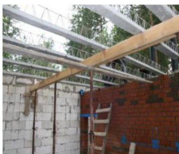
Рис. 9. Варианты монтажа промежуточных временных опор
