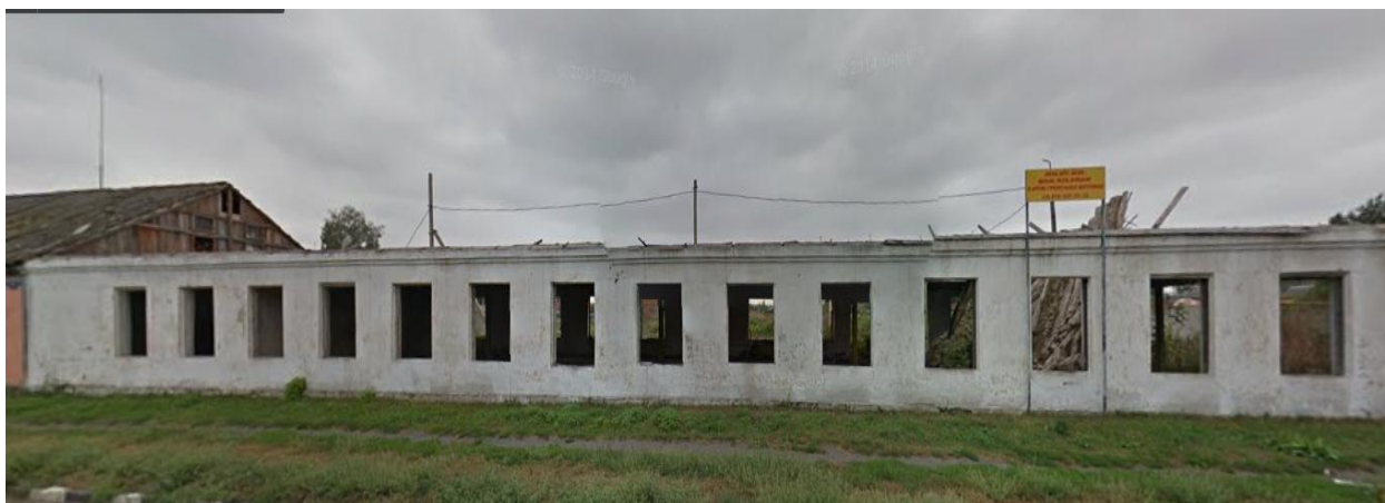
Рис. 1. Здание на улице Коминтерна ,39 а/1
